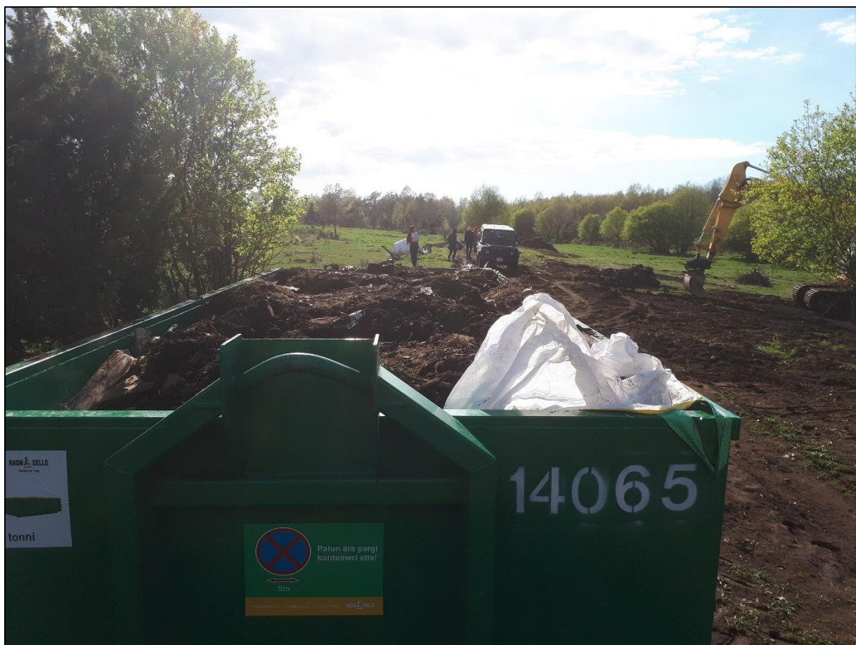
Foto 22. Prügifirma RagnSells 10 kuupmeetrine konteiner korjati ääreni prügi täis ja seejuures sorteeriti vanad eterniidi jäägid ning rehvid muust prügist eraldi. Foto: Lauri Klein.
